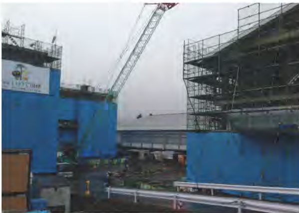
▲建設中の高田高等学校（2014年12月3日撮影）
